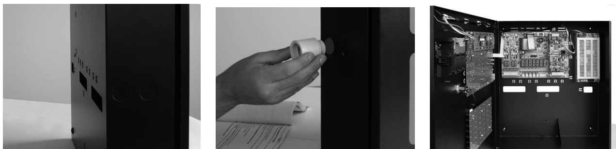
Rysunek 23 - Montaż centrali na ścianie
